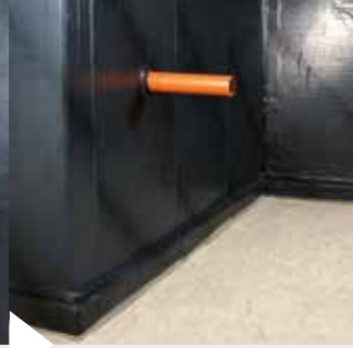
Afdichting is aangebracht.
