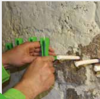
Plaatsen muurtap en capillair-staaf
