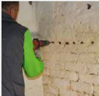
Horizontale boring in de voeg
