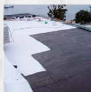
Afdichting op bitu- mendak
