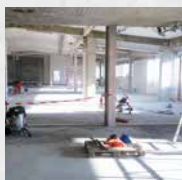
Sanering van pilaren
