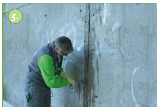
De scheur wordt voorbevochtigd.
