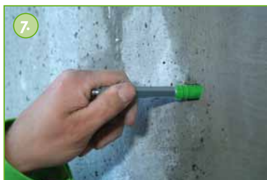
Vervolgens worden de Köster Superpackers in de boorgaten geplaatst, waarbij elk derde boorgat geopend blijft.
