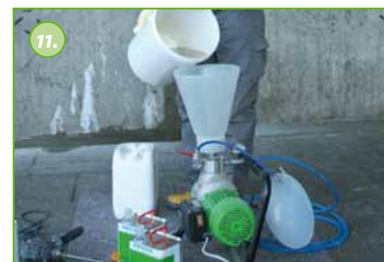
De injectiepomp wordt, als in de Köster handleiding beschreven, voorbereid. Vervolgens wordt de hars in de trechter gegoten. Hoeveelheid materiaal afstemmen op de verwerkingstijd.
