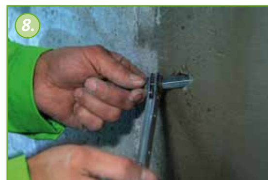
De packers aandraaien met een ringratel sleutel.
