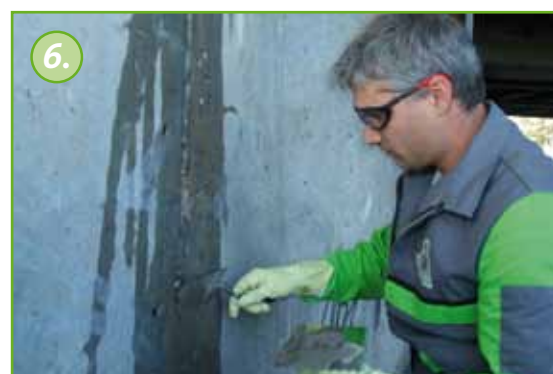
Aansluitend kan de scheur b.v. met Köster KB Fix 5 dichtgezet worden. Het dichten van de scheur verhindert, dat het injectiemateriaal voortijdig uit de scheur loopt.
