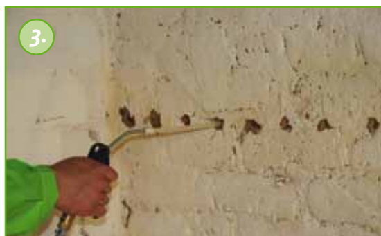
De boorstof uit de gaten verwijderen.
