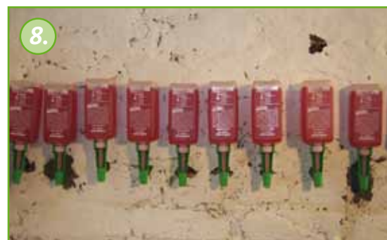
De drukloze injectie met Köster Crisin® 76 begint met de plaatsing van de flessen.
