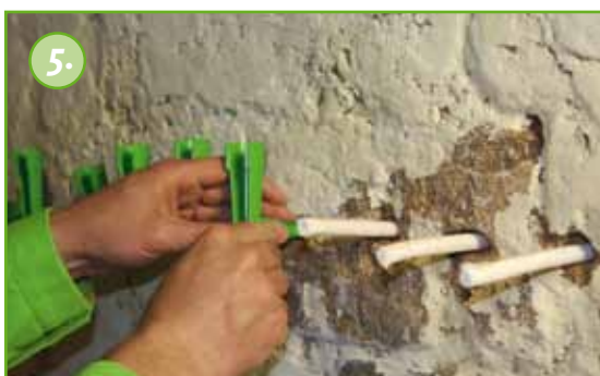
De Köster Muurtap zo monteren dat de capillairstaven tot in het voorraaddeel reiken.
