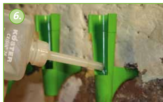
De voorraadhouder van de muurtap wordt met water gevuld om de capillairstaven zodanig te activeren dat ze opzwellen.
