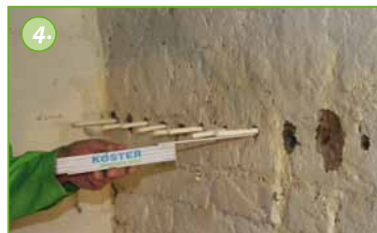
De Köster Capillairstaven worden zo verwerkt, dat de uiteinden 7 cm uitsteken.
