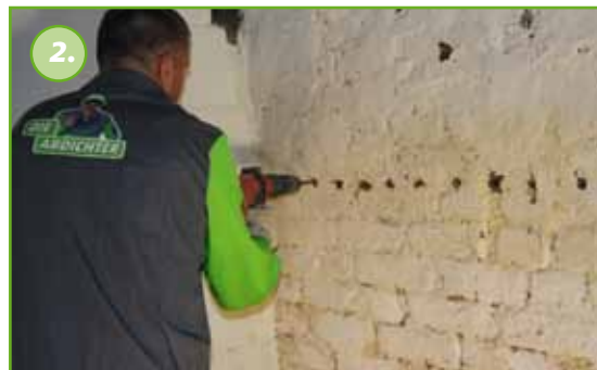
Gaten boren met een onderlinge afstand van 10 cm. Boordiepte in dit geval 40 cm (wanddikte 45 cm)
