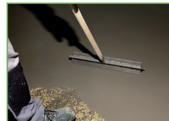
6. Aansluitend het materiaal met een stekelwals ontluchten
