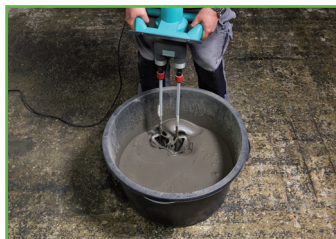
3. Met een geschikte menger minimaal 3 minuten mengen
