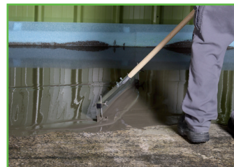
5. Op grotere vlakken wordt de SL Protect met een tandkamspaan verdeelt
