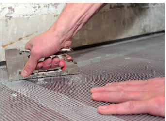
3. Opbrengen van KÖSTER wapeningsweefsel op de houten ondergrond
